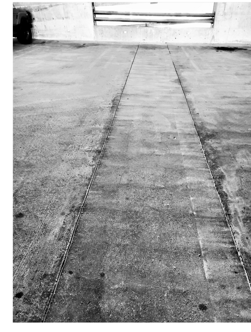
2 REPAIR 2 - POUR STRIP SEALING S201 1" = 1'-0"
