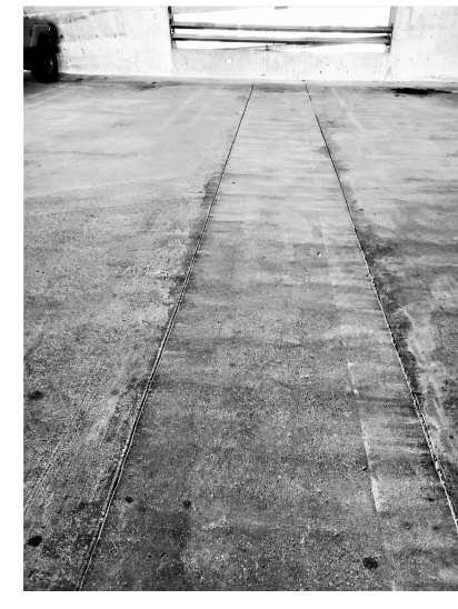
2 REPAIR 2 - POUR STRIP SEALING S201 1" = 1'-0"
